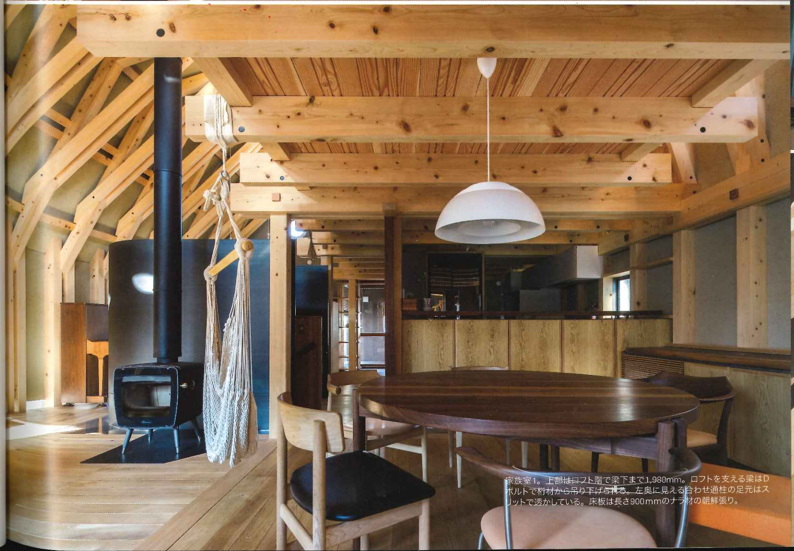
建具が開放された外室。内外が一体となった空間から家族室まで見通せる。外室の床は連続梁の間にヒノギ板差し込み。
